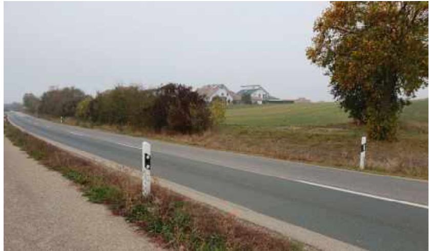
Foto 3: Blick auf die Kreisstraße 3209 in Richtung Nordwesten (das Plangebiet befindet sich rechts)
